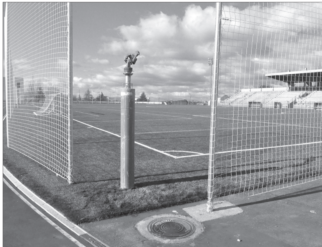
Detalle del nuevo césped, vallado perimetral y nuevo sistema de riego en el campo de fútbol. / JAVIER MILENA.
